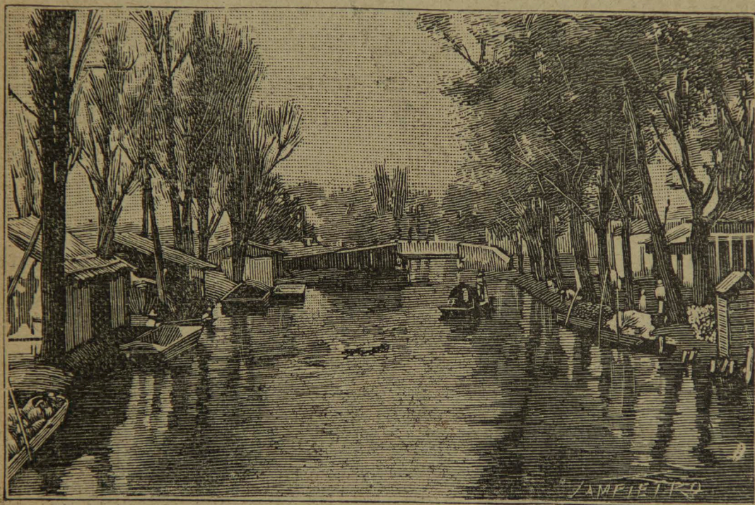
Distrito federal.—Canal de la Viga.
