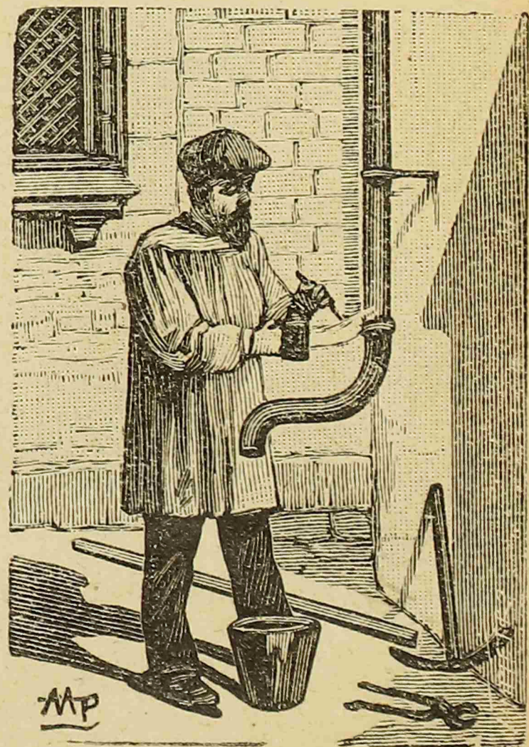
Tubería de plomo
