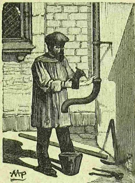
Obrero soldando con estaño la junta de una tubería de plomo.
