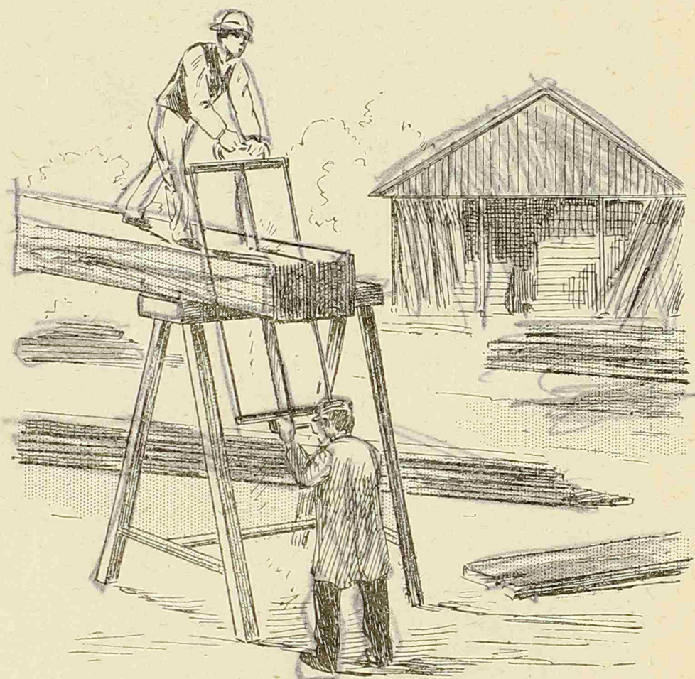
FIG. 23. — Aserrando una viga.
