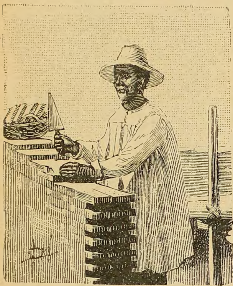
Albañil construyendo una pared de ladrillos
