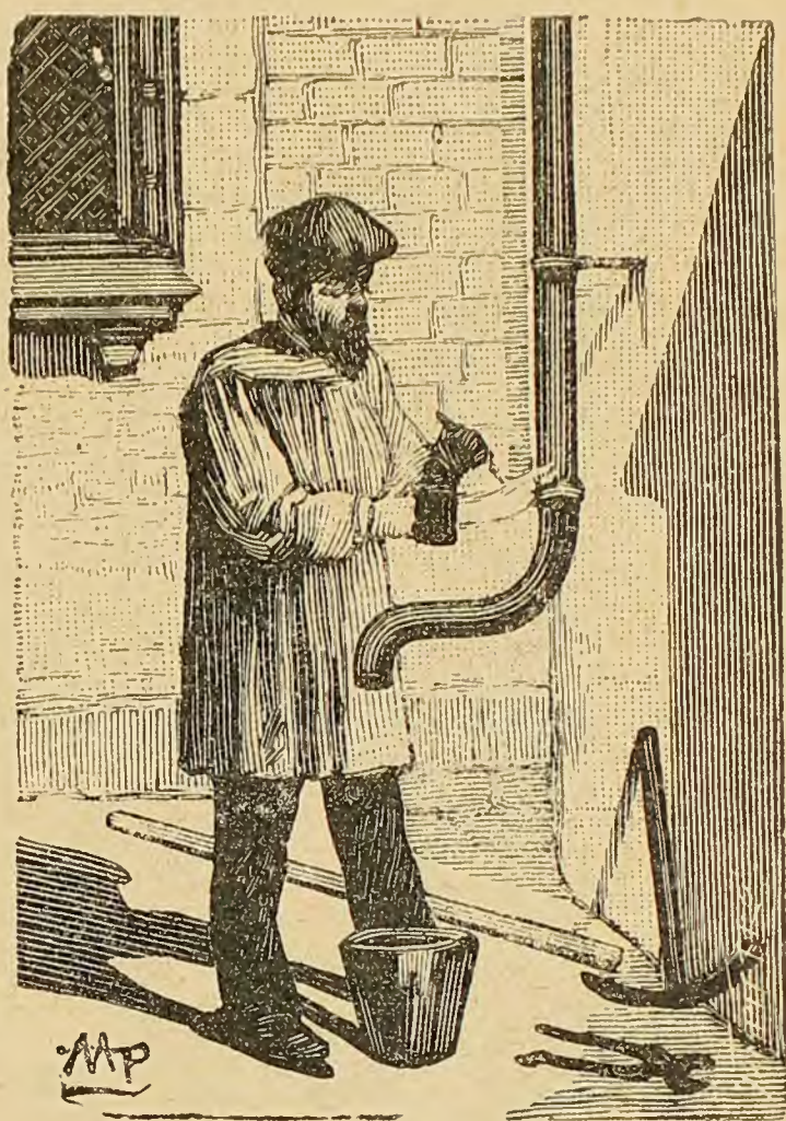
Plomero soldando una tubería
