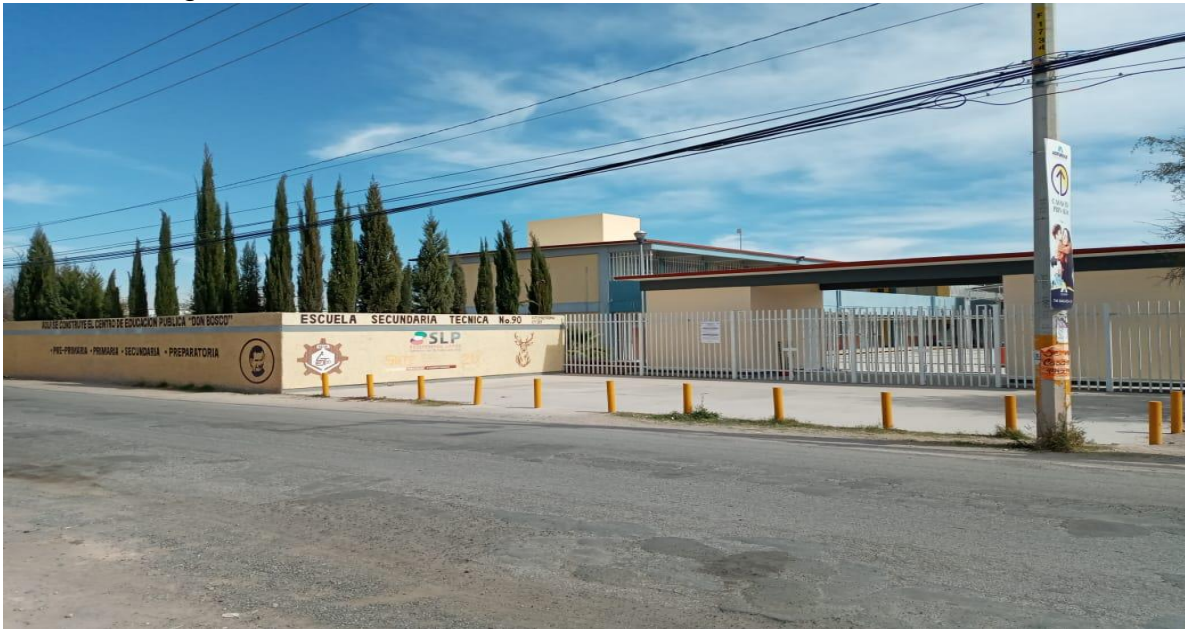
Imagen 1. Fachada actual de la Escuela Secundaria Técnica 90
