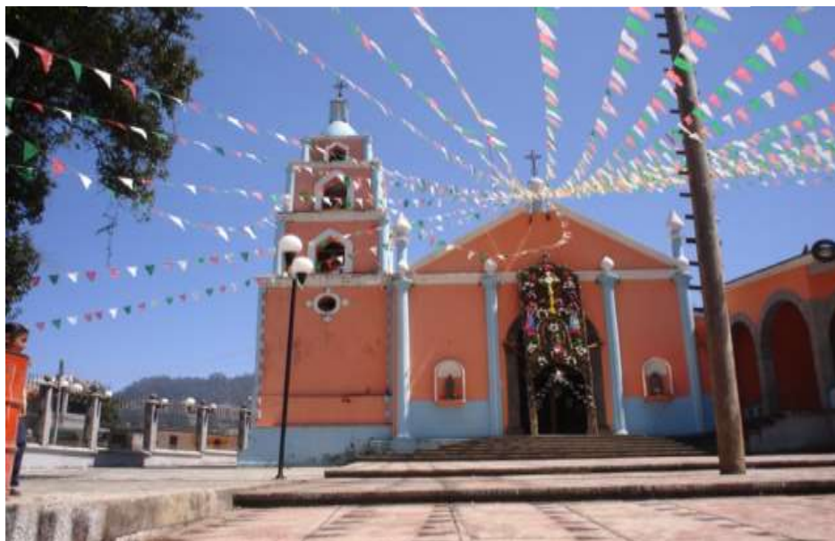
Fotografía de la iglesia de Quimixtlan en la actualidad, se muestra el cambio físico y mejoras que a través de los años se han presentado.
