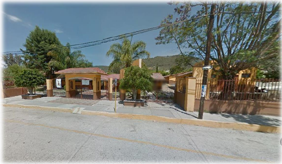
Fachada de la Escuela Primaria Lázaro Cárdenas del Río.
