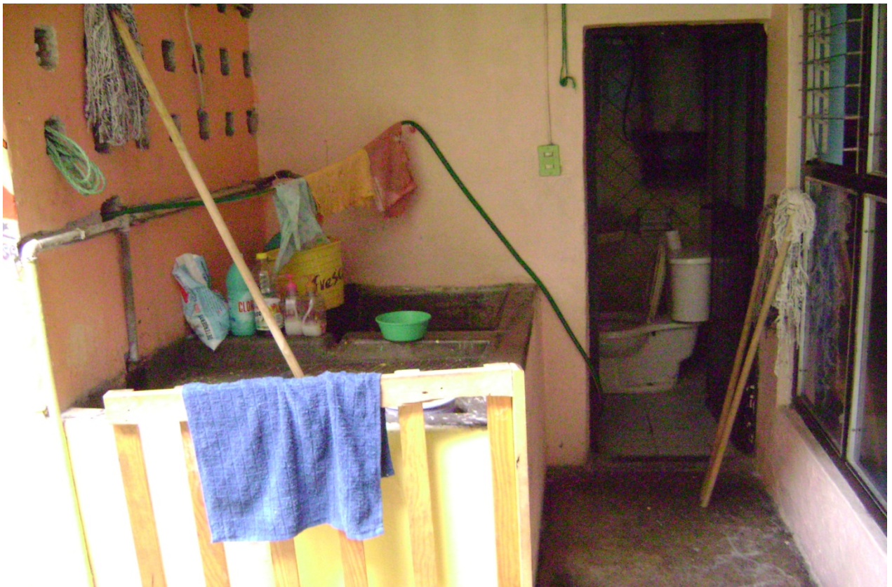
Área de mantenimiento, lavadero y baño.
