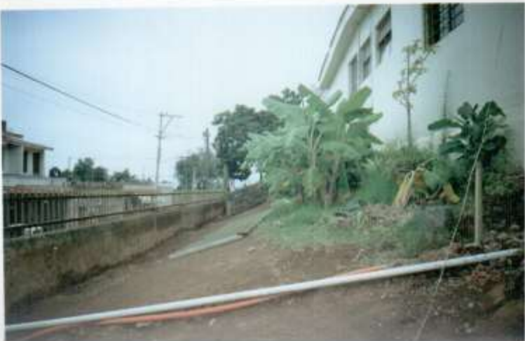
FOTOGRAFÍA No. 6 CUANDO LLEGUE ENCONTRE LA FACHADA EN REPARACIÓN
