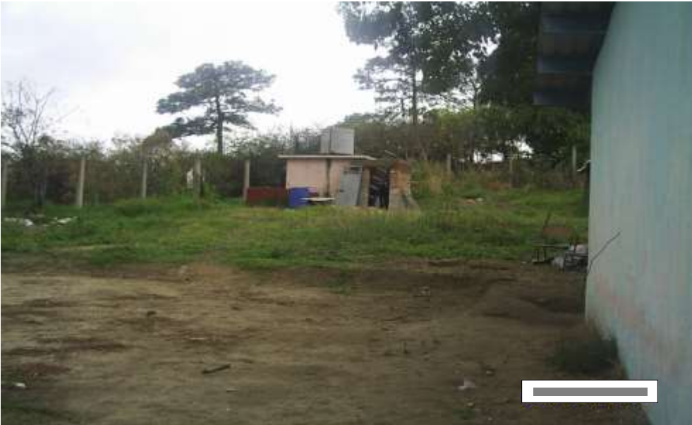
Baños en la escuela visitada
