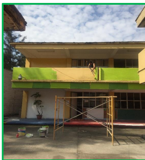
Figura 32 Pintura exterior del inmueble, con andamio de la inmobiliaria
