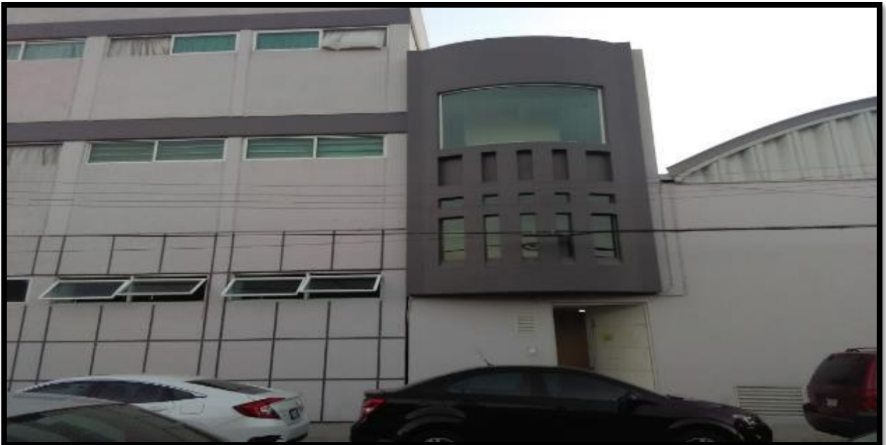
Foto No. 2 Entrada anexa por la calle Antonio Vivaldi
