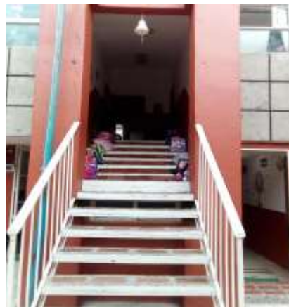
Fotografía 9. Escaleras para acceso a la planta alta.
