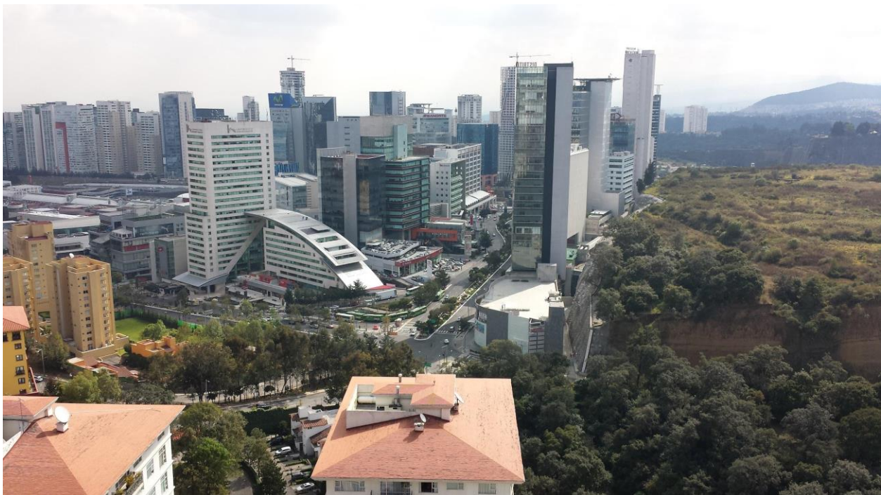
Fotografía 1. Panorámica de Santa Fe
