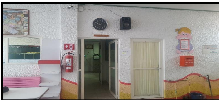
Foto No. 6: Edificio 1 C.D. y B. I. No. 7. Área administrativa, filtro, entrada.
