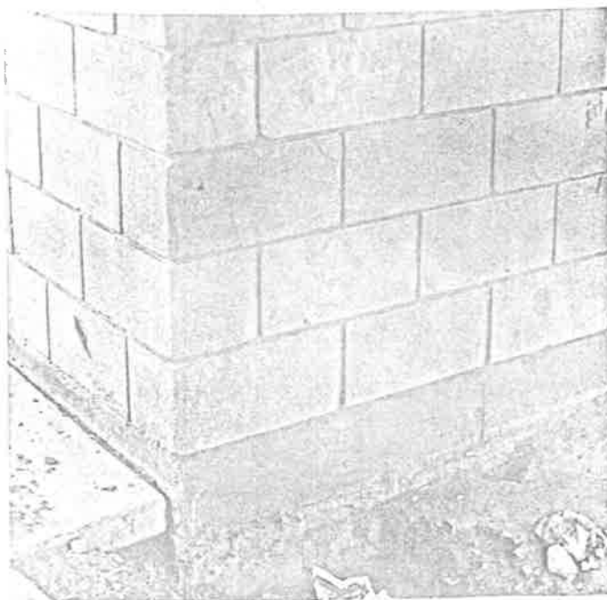
Fig. No. 9 Antes de la reconstrucción
