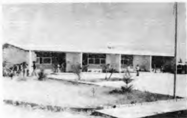
Aulas de la Escuela en su Primera Etapa.
