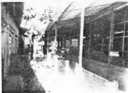
Salones con techos de material no adecuado.
