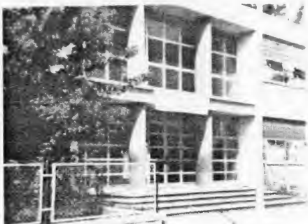
Frente de la Escuela Primaria Urbana Núm. 2 "Centro Escolar Moroleón"
