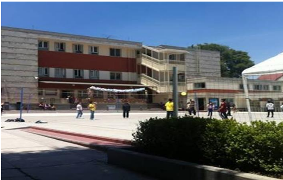
EDIFICIO DE PRIMARIA (primer y segundo piso, al centro), DIRECCIÓN GENERAL, DIRECCIÓN PRIMARIA, OFICINAS RECURSOS HUMANOS Y CONSULTORIO MÉDICO (parte central, planta baja), BIBLIOTECA Y ESCALERAS DE EMERGENCIA (a la derecha). PATIO CENTRAL PRIMARIA.
