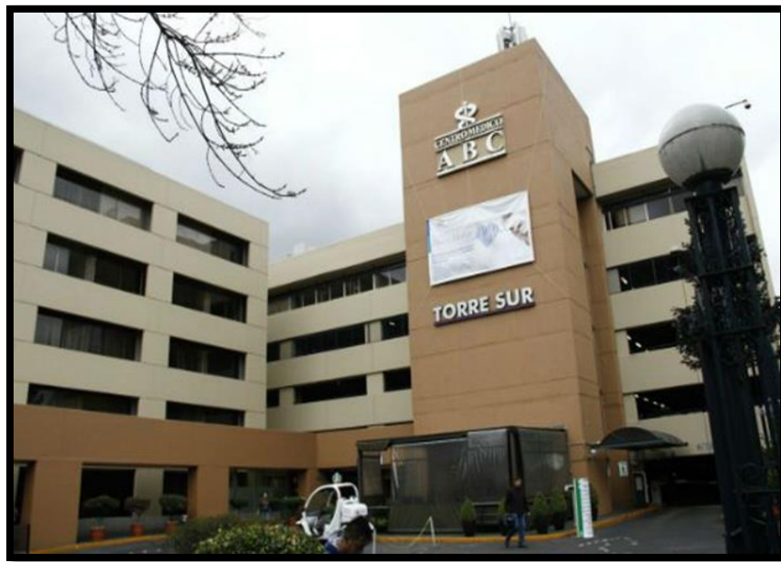
Entrada de urgencias hospital ABC observatorio
