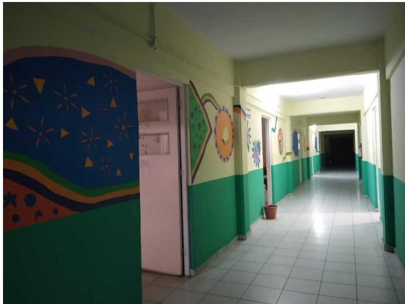
Pasillo a dormitorios Piso 2
