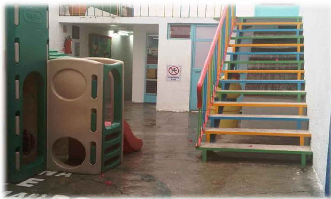
Imagen 9. Parte interior del Centro Desarrollo Infantil “Solecito”, ubicación de los baños y de las escaleras del segundo piso del jardín de niños. 25
