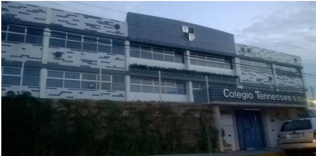
Fachada del Colegio Tennessee. S.C Fuente: Propia.
