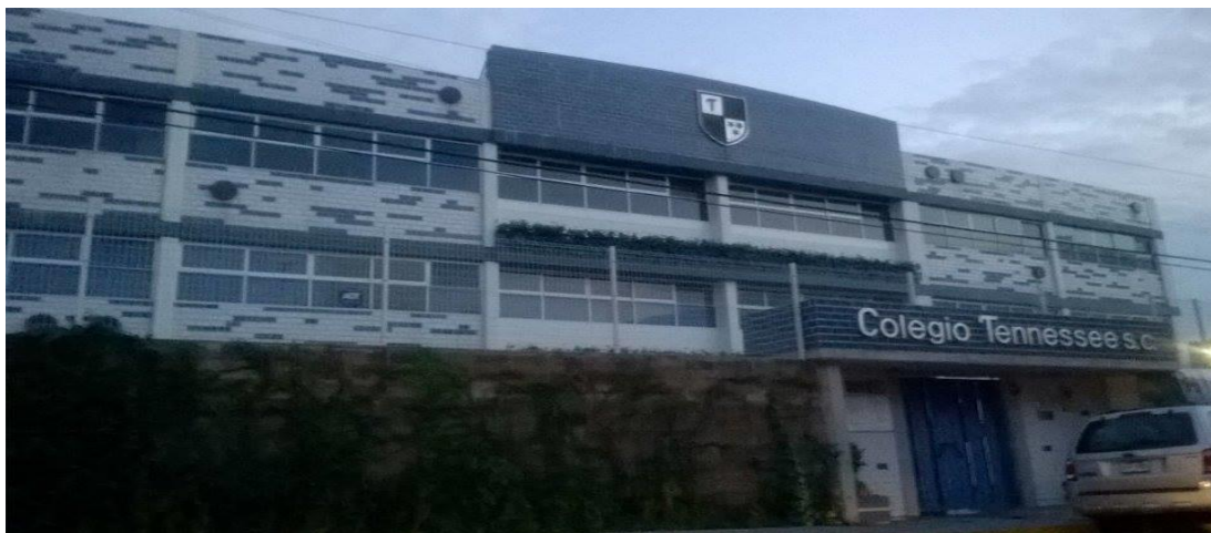
Fachada exterior del colegio: Fuente propia.
