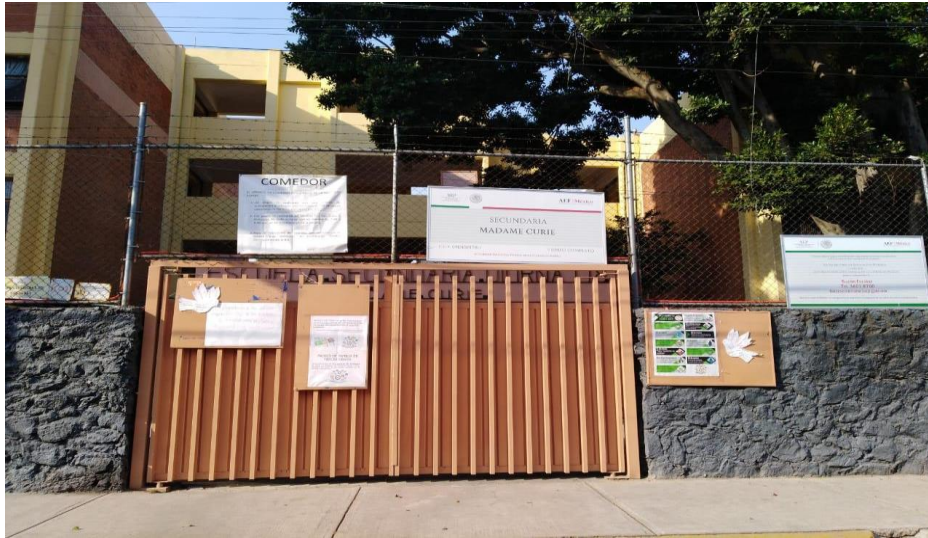
Figura 15. Entrada de la Escuela Secundaria
