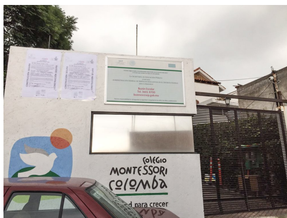
Foto 11: Fachada de la Escuela
