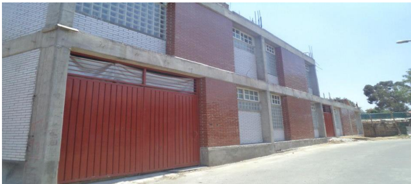
Fotografía 4. Estado actual del Centro Comunitario de Desarrollo Infantil "Los Pequeños de Villalpando A.C". Fuente: Propia.
