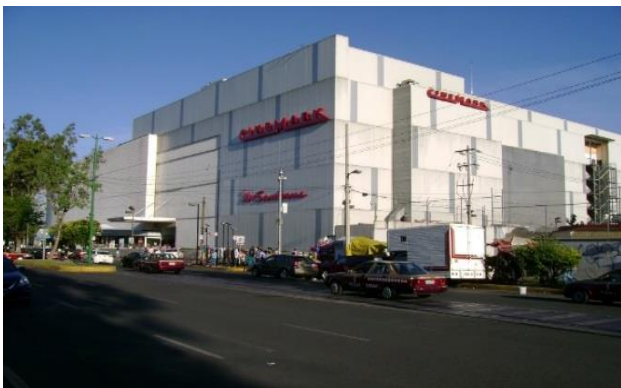
Imagen 12. Centro Comercial Parque Lindavista Fuente: https://www.google.com.mx
