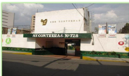
Imagen 3.3 Exterior del Centro de Seguridad Social Contreras
