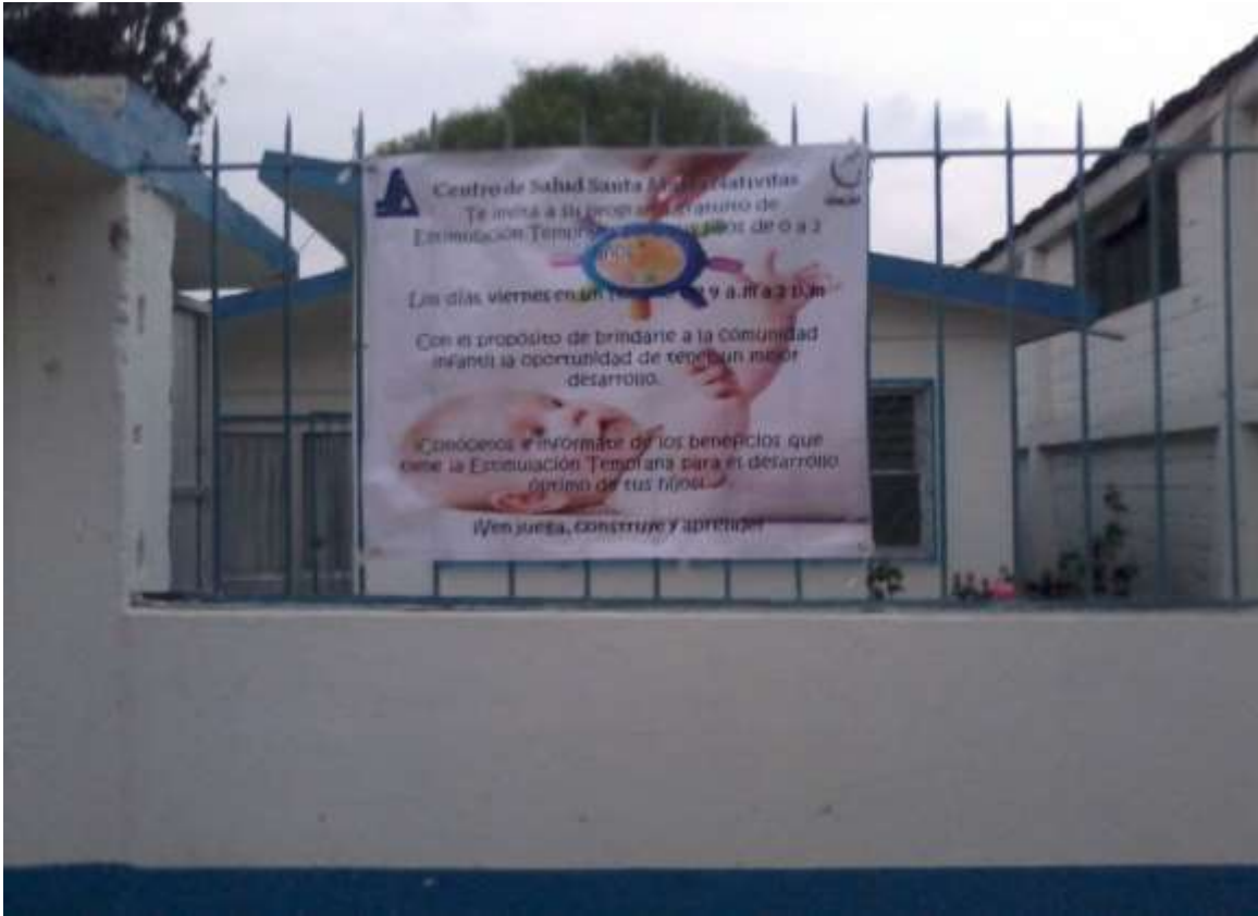
Colocación de lona informativa, en la fachada del Centro de Salud
