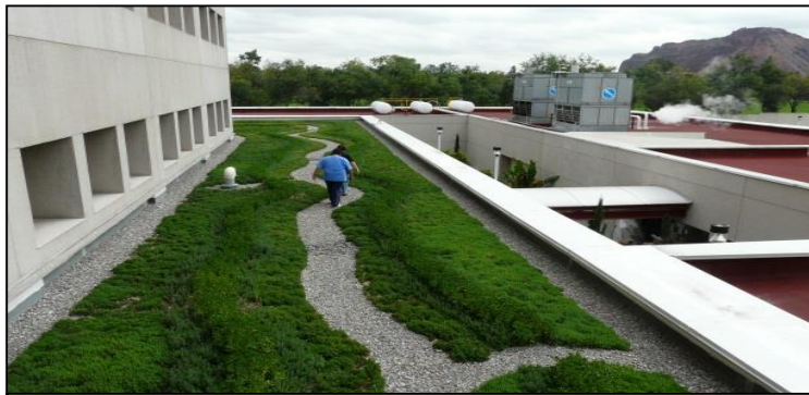
Imagen 11: Azotea Verde Hospital Belisario
