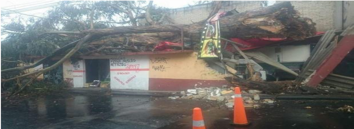
Imagen 6. Zona de derrumbe e inundación (alto riesgo) en tiempo de lluvia. 6
