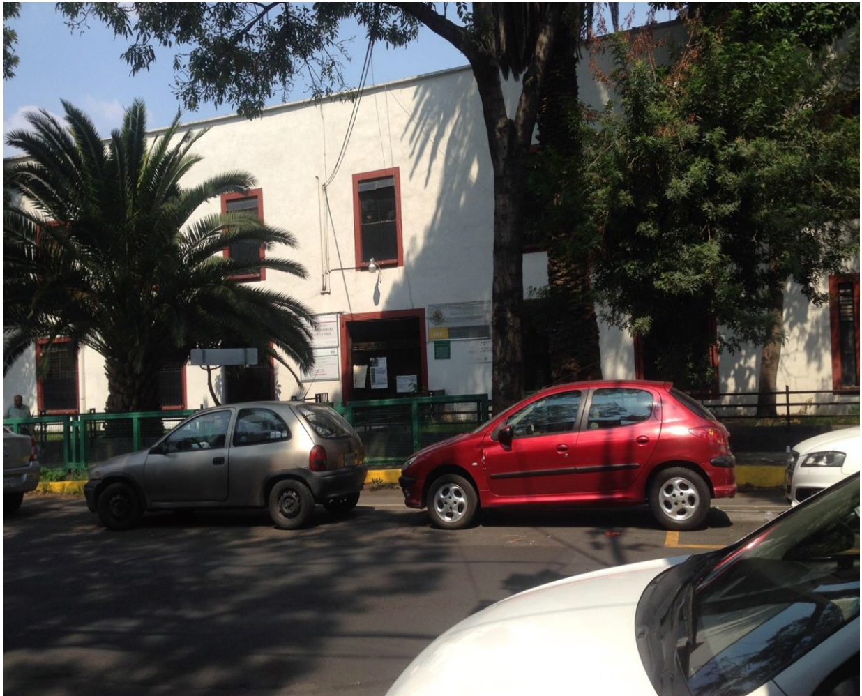
Figura 8. Fachada del internado
