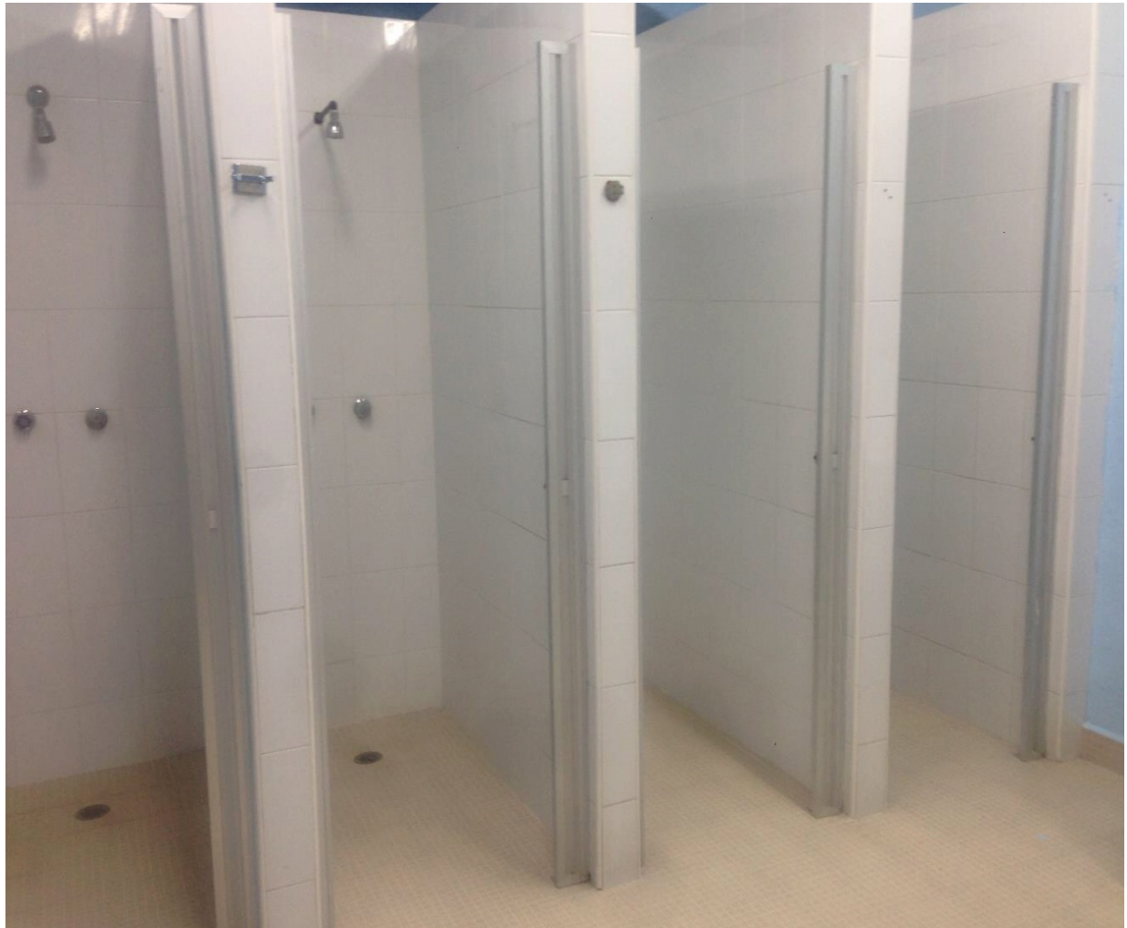
Figura 19. Regaderas del dormitorio de niños
