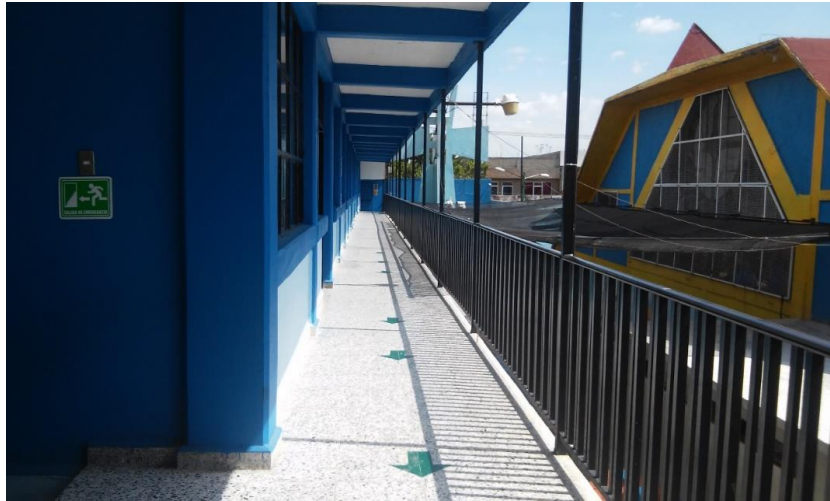
Foto 5. Vista del primer piso Fuente: Propia
