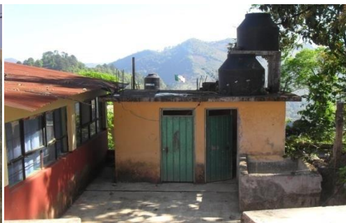
FOTO NO.2 BAÑOS
