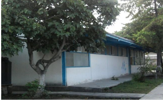
Cocina COPUSI, antes centro de salud
