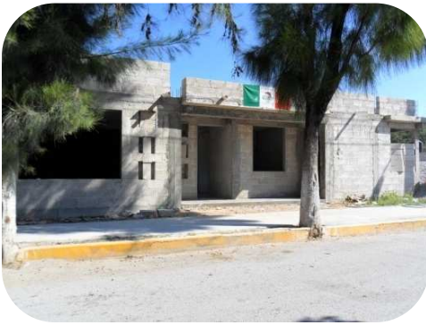
Oficinas de Juzgado Auxiliar en construcción
