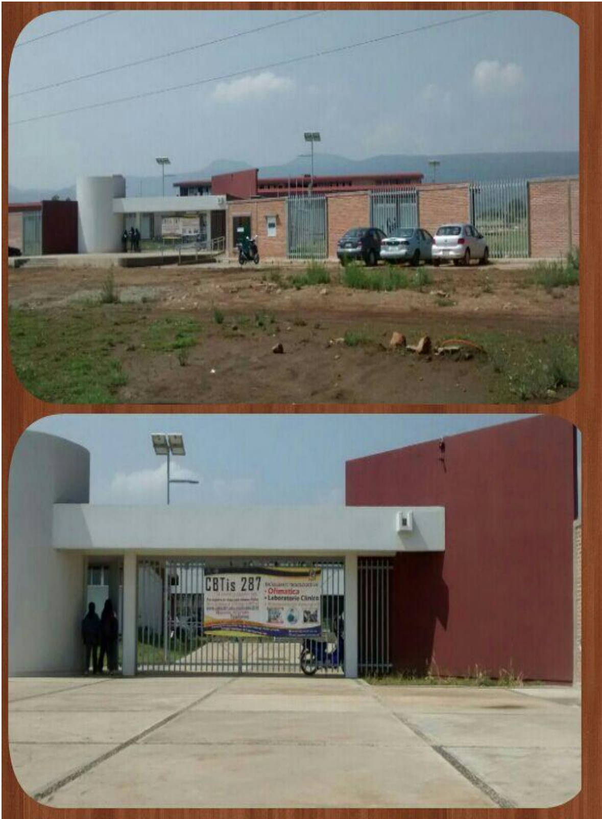
Fachada principal del CBTis 287, Santiago Tulantepec.
