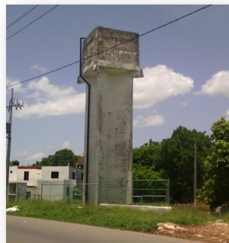
Depósito de Agua
