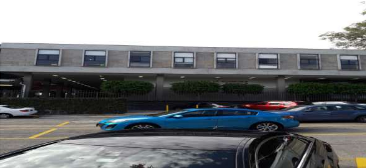
Foto del edificio B ó anexo de la Facultad ubicado en el estacionamiento.
