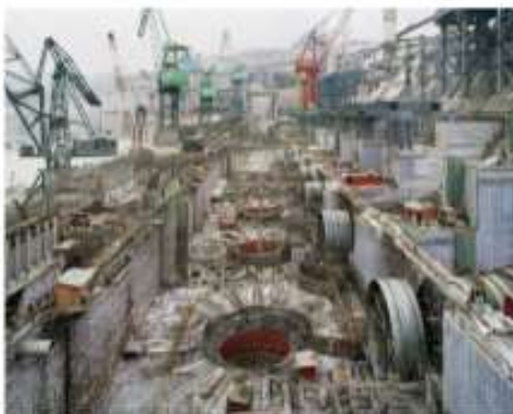
Imagen de la construcción de la presa de las tres gargantas
