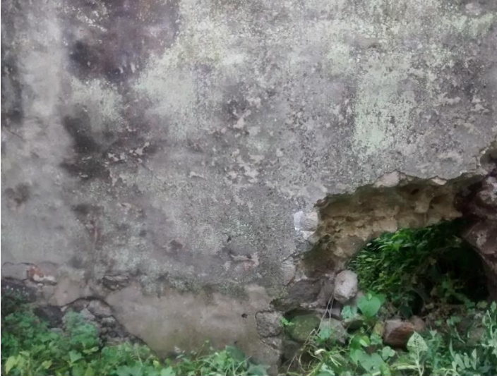
Fotografía 6 Agujero en la base. 5 de octubre de 2016. (Foto de Torres Hernández, J. L).
