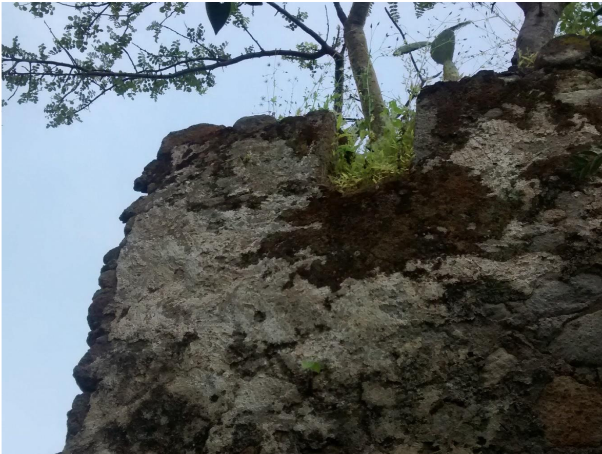
Fotografía 8 La estructura del techo de la capilla. 5 de octubre de 2016. (Foto de Torres Hernández, J. L).
