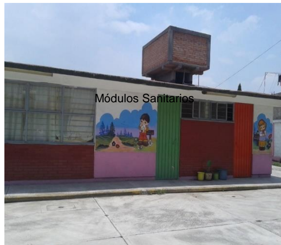
Módulos de sanitarios.
