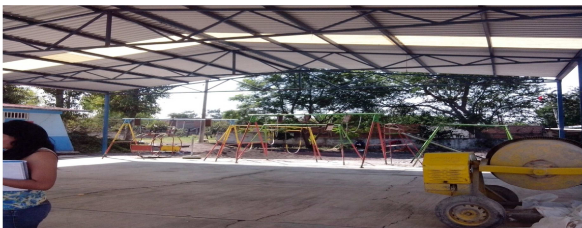
Instalaciones en proceso de construcción, remodelación del preescolar
