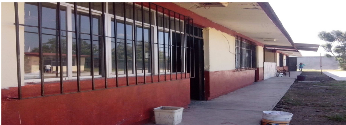
Aulas telesecundaria 4 salones con grupo una dirección
