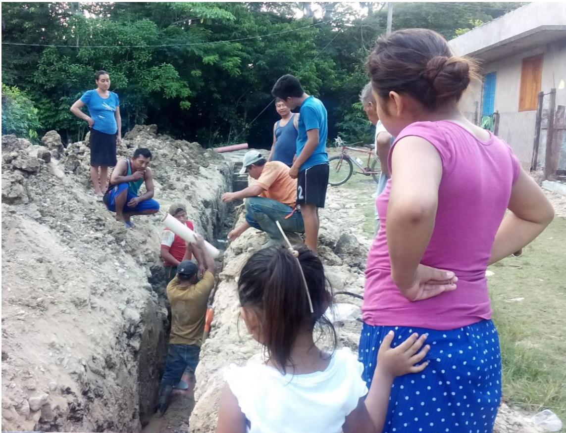
Supervisando la remodelación del drenaje. Fotografía tomada por Seydi
