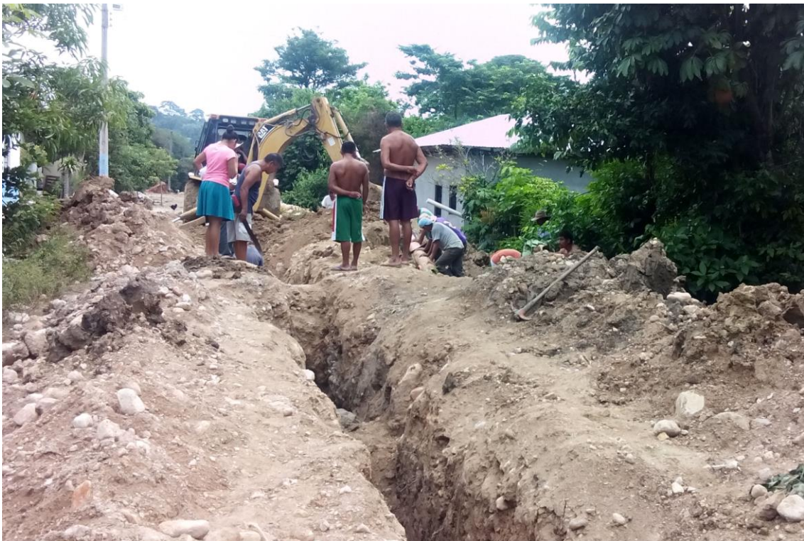
Supervisando la remodelación del drenaje. Fotografía tomada por Seydi
