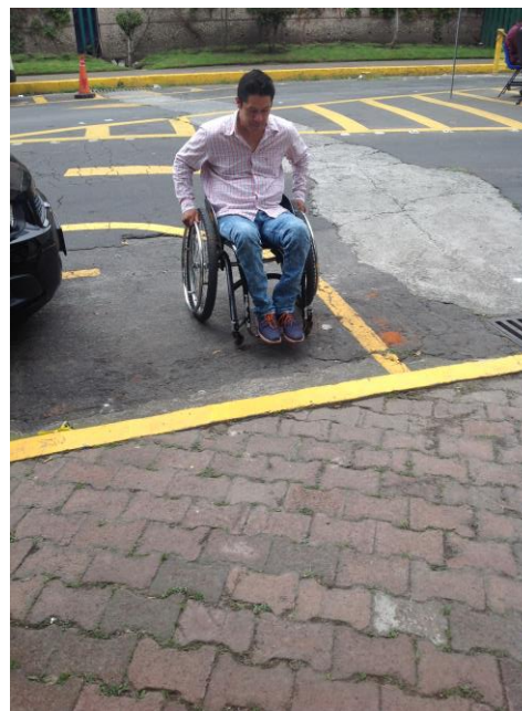
Imagen 1: En la entrada principal no hay rampas de acceso.
