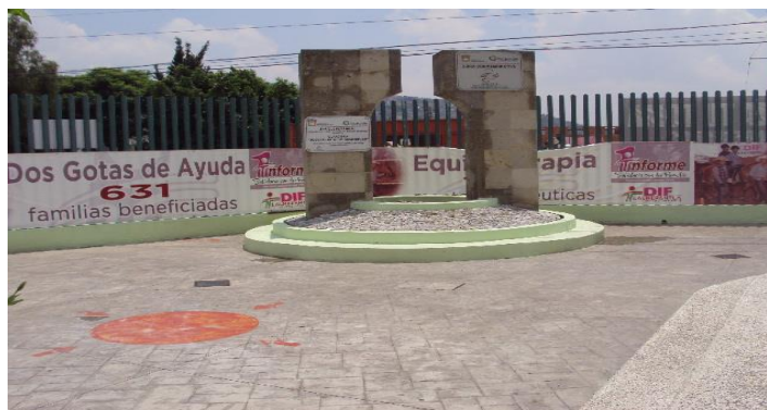
Patio principal y entrada.
