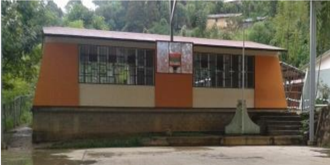
Ilustración 8 aulas con ventilador
