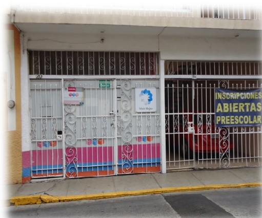
Fotografía N° 4 Fachada del Centro Educativo Jean Piaget febrero 2012
