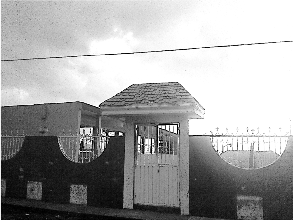
ANEXO 4 FACHADA DE LOS SALONES DE CLASE
