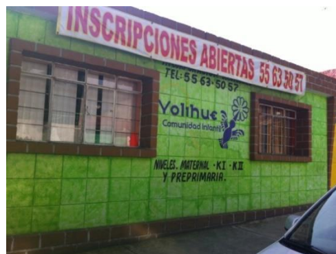
Fachada de la Comunidad Infantil "Yolihue". Fuente: propia
