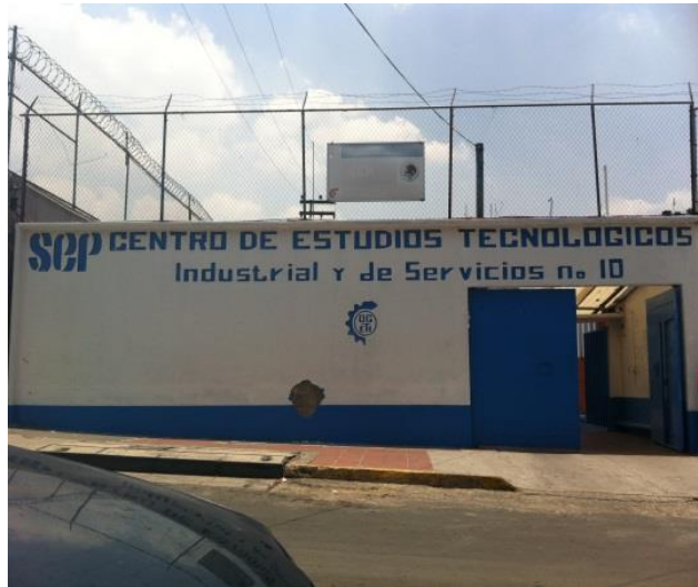
Fachada del CETis 10. Fuente: Propia
